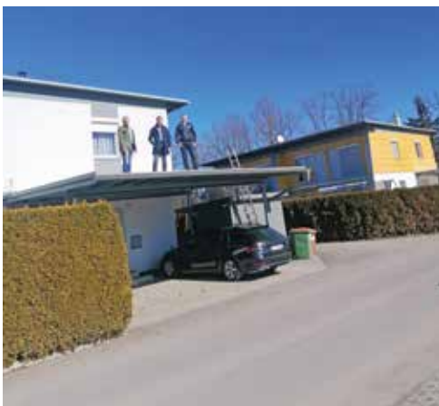
Insgesamt drei Haushalte schlossen sich zu einem gemeinsamen PV-Projekt zusammen.
